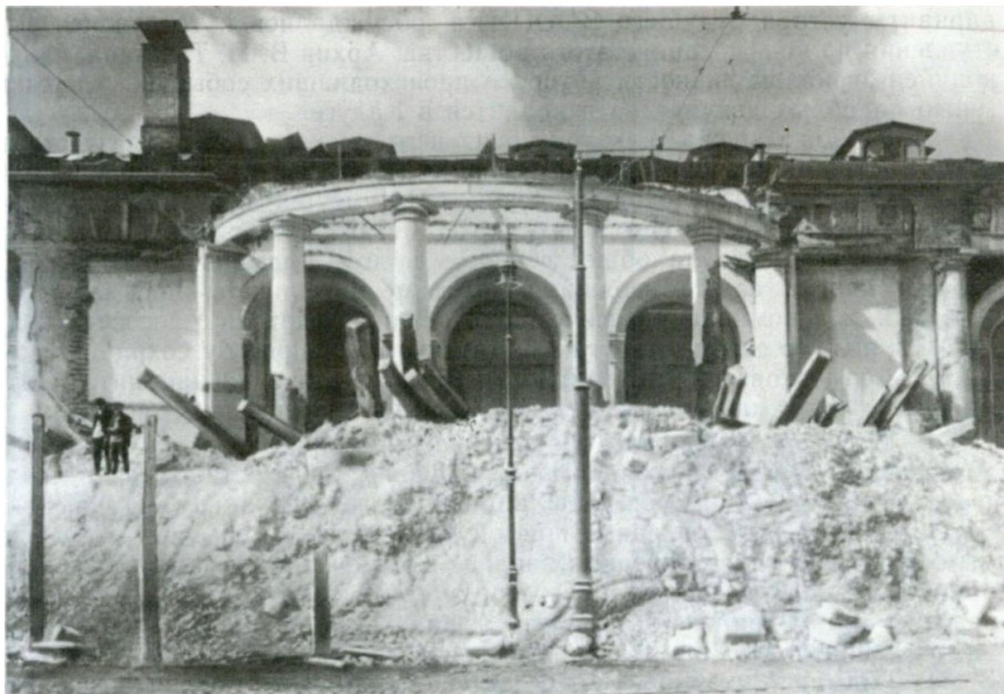
Рис. 5. Разрушение Никольской церкви. Фото 1930–1931 гг.
